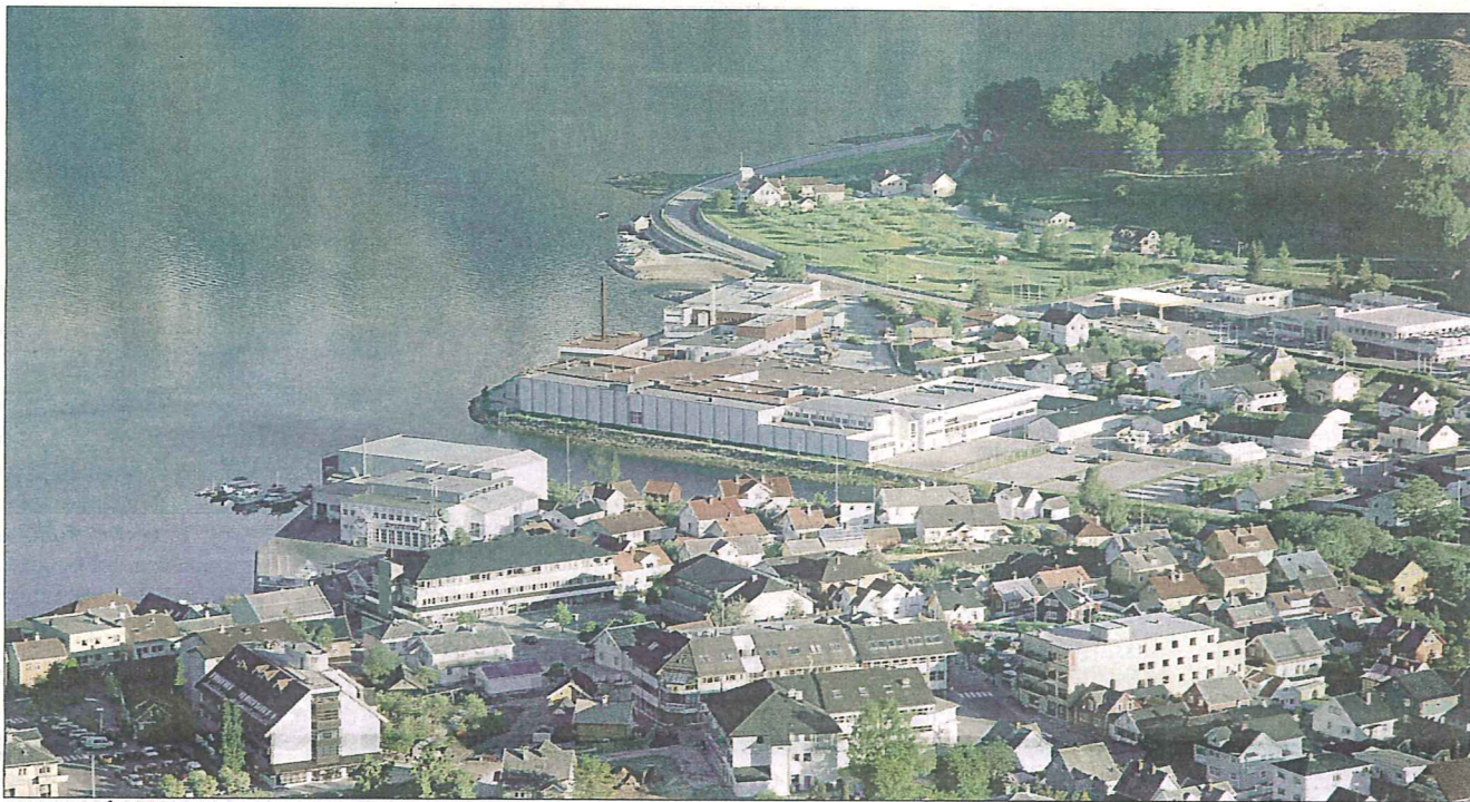
ENERGI FRÅ SJØEN: Sognekraft har søkt om konsesjon på eit fjernvarmeanlegg i Sogndal. Løysinga er sjøvassbasert og syter for både varme eller kjøling i dei tilknytt bygningane. Sjøvatnet blir henta i fjorden ved utløpet av Sogndalselvi.
