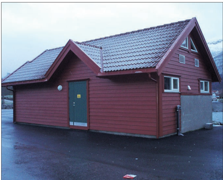
Sjøvatnet vert pumpa opp i eit slikt vekslarhus, som gjennom eit røyrrnett sender vatnet ut til kundane i Nordfjordeid.
