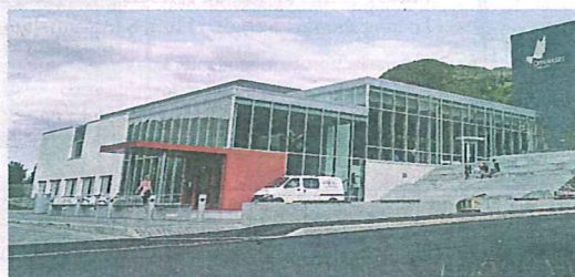
Eid vidaregåande skule og Operahuset Nordfjord hentar varme og kjøling frå fjordvarmeanlegget. Dei tekniske installasjonane er prosjektert av Riksheim Consulting AS og levert av YIT AS.
